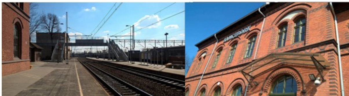
Fotografia 1 Zmodernizowana stacja i dworzec kolejowy w Kluczborku
